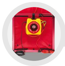
Test d'étanchéité à l'air des bâtiments
