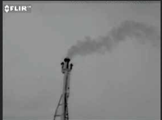
VISUALISEZ CLAIEMENT LES FUITES D'HYDROCARBURES
