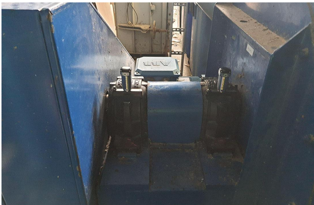
Image 3 Les capteurs Airius sont installés sur les paliers du roulement.
